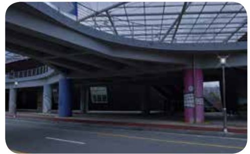
설치장소 계양경기장 가로등 설치제품 OBB-80S L+ -5700K
