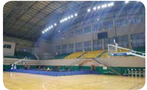
설치장소 안산시 와동체육관 설치제품 CD3000-150W-B2-P
