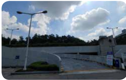
설치장소 고양문화재단 가로등 설치제품 OBB-80S L+ -5700K
