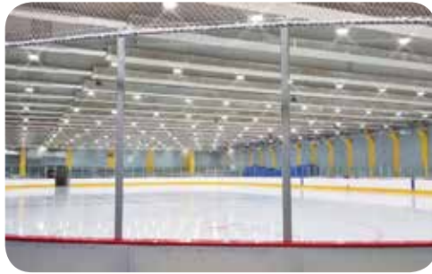
설치장소 고양도시관리공사 실내빙상장 설치제품 IH2-80S-57K
