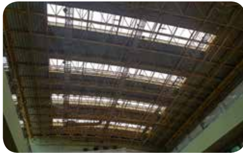
설치장소 금천구민문화체육센터 실내체육관 설치제품 IH2-100S-57K
