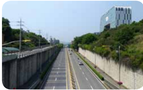
설치장소 대전 동구청로 구간 가로등 설치제품 OB230c-100S-5700K
