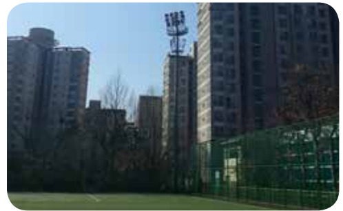
설치장소 천마체육공원 축구장 설치제품 CT8000S-700W-B3-A-P
