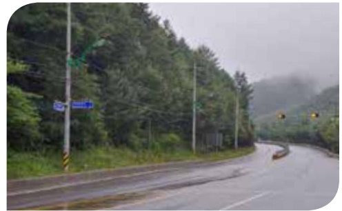
설치장소 강원 태백시 가로등 설치제품 OB230c-100S-5700K
