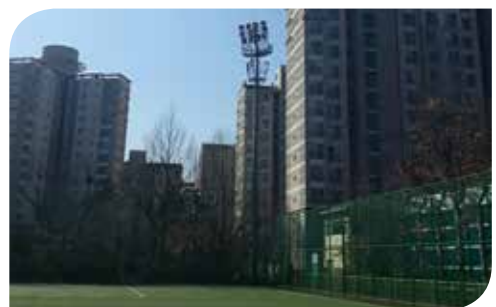
설치장소 천마체육공원 축구장 설치제품 CT8000S-700W-B3-A-P
