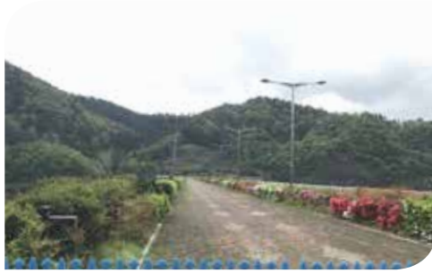
설치장소 장흥 수자원공사 설치제품 OBB-60S L+ -5700K
