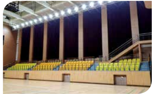
설치장소 장수군 시설관리사업소 다목적 체육관 설치제품 IH2-100S-57K
