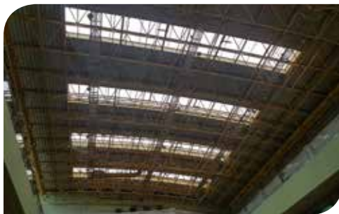
설치장소 금천구민문화체육센터 실내체육관 설치제품 IH2-100S-57K
