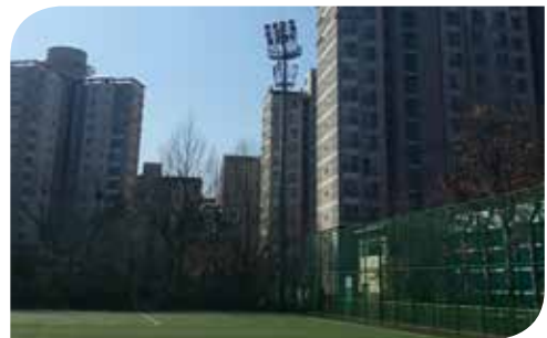
설치장소 천마체육공원 축구장 설치제품 CT8000S-700W-B3-A-P
