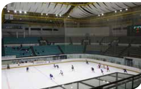
설치장소 목동 아이스링크 설치제품 ITCA-800
