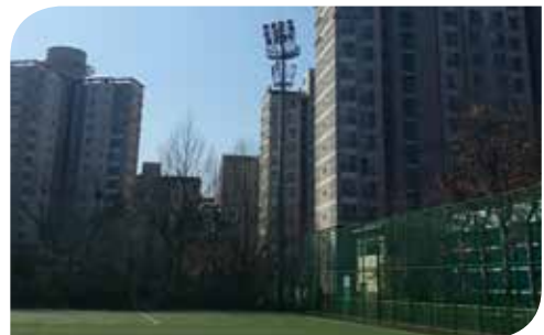
설치장소 천마체육공원 축구장 설치제품 CT8000S-700W-B3-A-P
