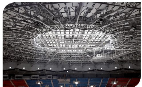
설치장소 올림픽 체조 경기장 설치제품 ITCA-800
