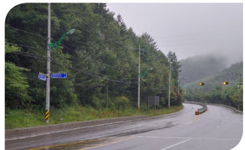
설치장소 강원 태백시 가로등 설치제품 OB230c-100S-5700K
