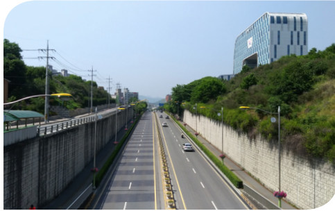
설치장소 대전 동구청로 구간 가로등 설치제품 OB230c-100S-5700K
