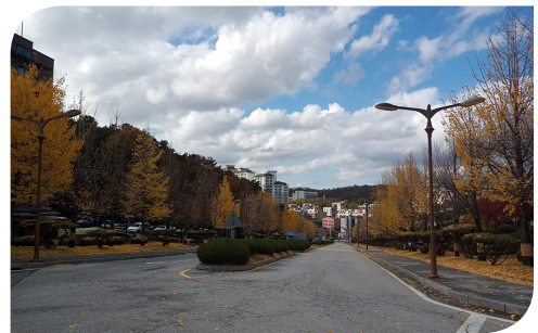
설치장소 백석대학교 교내 가로등 설치제품 OB230c-100S-5700K
