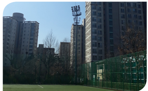
설치장소 천마체육공원 축구장 설치제품 CT8000S-700W-B3-A-P
