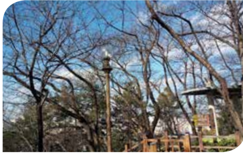
설치장소 대전 중구 테미근린공원 설치제품 IB3-50CL
