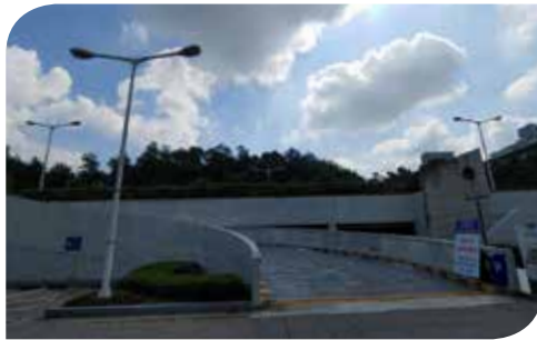
설치장소 고양문화재단 가로등 설치제품 OBB-80S L+ -5700K
