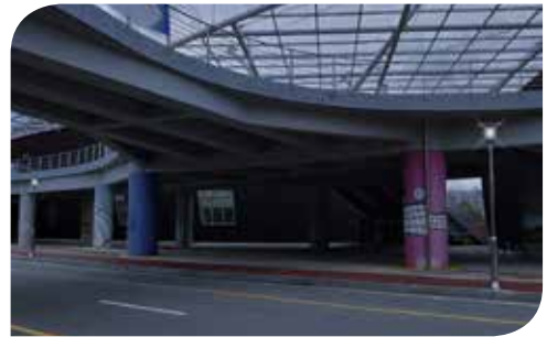
설치장소 계양경기장 가로등 설치제품 OBB-80S L+ -5700K
