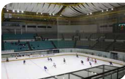
설치장소 목동 아이스링크 설치제품 ITCA-800
