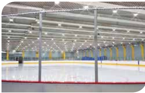
설치장소 고양도시관리공사 실내빙상장 설치제품 IH2-80S-57K
