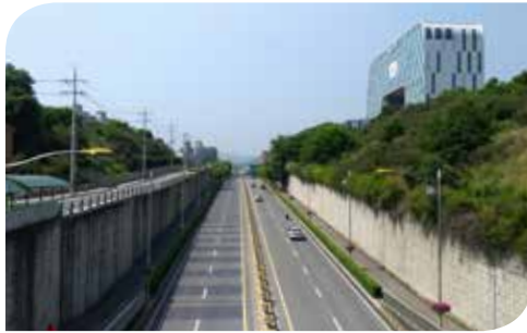
설치장소 대전 동구청로 구간 가로등 설치제품 OB230c-100S-5700K
