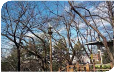
설치장소 대전 중구 테미근린공원 설치제품 IB3-50CL
