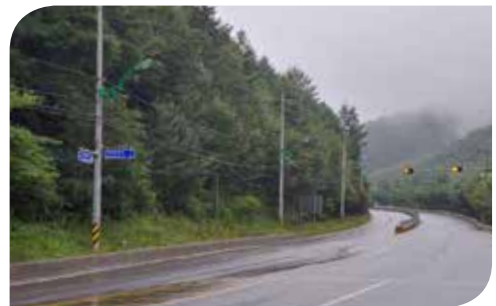
설치장소 강원 태백시 가로등 설치제품 OB230c-100S-5700K
